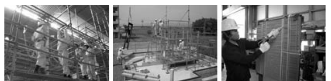
足場の組立 (作業床設置中) 木造組立作業中 (鉄骨造の組立も実施) シーリング作業
