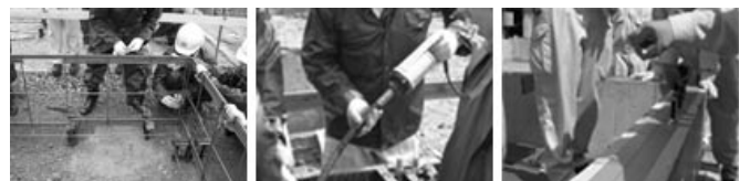
鉄筋の組立 パイプブLOWER (コンクリート打設) 墨出
