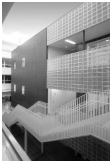
基礎杭を再利用して新たに増築した中央棟
