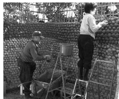
上：コンクリート団子の施工の様子 左：URC工法の壁面
