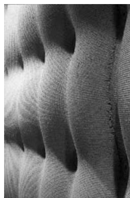
上：コンクリート団子の施工の様子 左：URC工法の壁面
