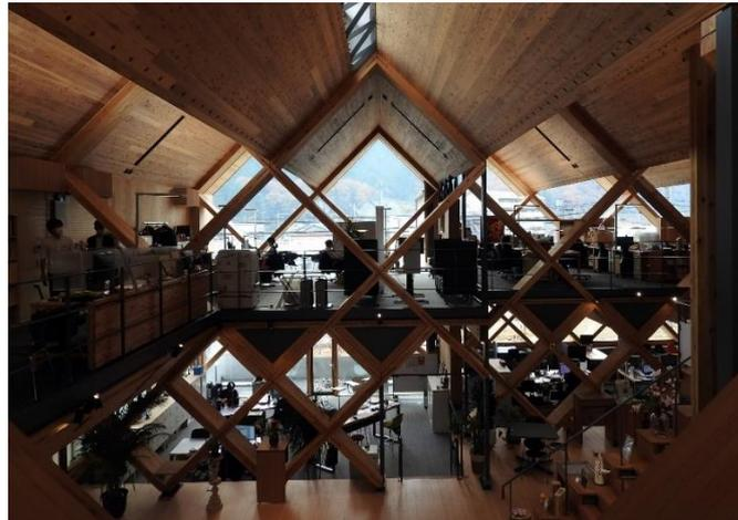
集成材（断面 600×150 mm、一部 300×150 mm 2 丁合せ）の菱組構面を東西方向に 4 通り並べて配置、筋違の機能も果たしています。直交方向耐力壁は 5 層 5 プライ厚 150 mm スギ CLT です。2 階床は 5 層 5 プライ厚 150 mm ヒノキ CLT の V 字形梁の上に 3 層 4 プライ厚 120 mm スギ CLT を水平に、屋根は 3 層 4 プライ厚 120 mm スギ CLT の V 字形梁を、それぞれ菱組構面に架け、一部の柱や壁の一部に鉄骨構造が併用されています。木材使用量は、集成材オウシュウアカマツ 66.72 m<sup>3</sup>、CLT スギ 210.29 m<sup>3</sup>・ヒノキ 67.46 m<sup>3</sup>とのことです。
