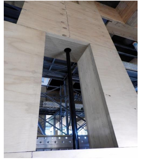
PC 棒鋼でポストテンション導入
