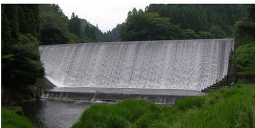
**白水ダム**：落差 14m の白水溜池堰堤の曲面の白糸のような流れから「日本一美しいダム」とも言われています。左端には「武者返し」と呼ばれる曲面流路、右端には階段流路があり、曲線美の堤です。細くなくね道の先あり、ナビの無い時代、到達には苦労しました。(写真撮影：2007.06.30)
