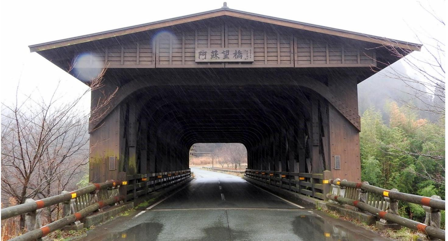
屋根付き木造ラチストラス橋「阿蘇望橋」です。全国に木造橋はたくさんありますが、屋根付きは神社や庭園等以外では珍しく、ここが車道では最初のものとのことです。長さ41.6m・幅員7m・車道部地上高4.5mで、1999年竣工。木材は地場産材の主に杉・桧の集成材を用いて、トラス下弦材に鋼材も使ったハイブリッド構造、アスファルト路面の下にはプレストレスが導入された集成材の木床版があります。木材使用量は集成材265.55m<sup>3</sup>+製材(屋根・外壁)79.52m<sup>3</sup>の合計345.07m<sup>3</sup>で、屋根を付けることで、少なくとも2倍以上の耐久性が期待できるとのことです。
