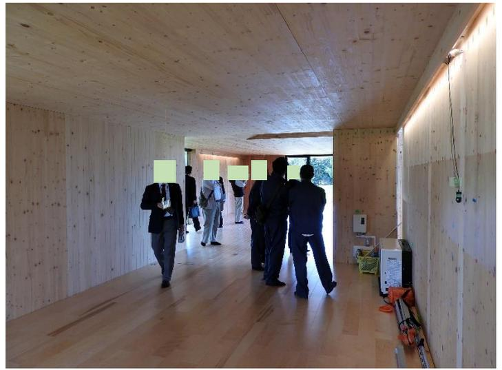
壁・天井はCLT現し、床は小幅度で仕上げ
