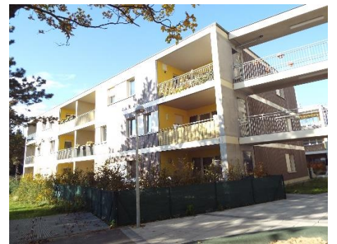
2・3階に屋根付き渡り廊下
