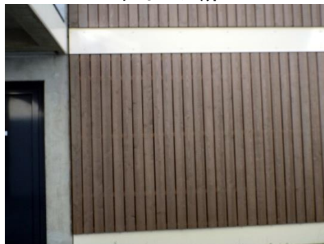
スリットを設けた板張り外装
