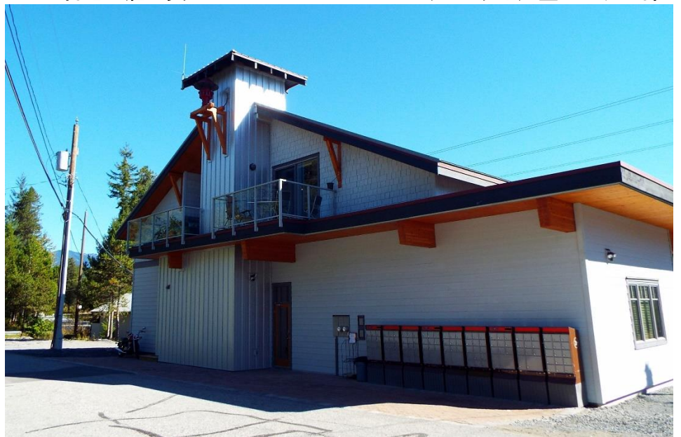
ホース乾燥塔は、以前のものを残して活用
