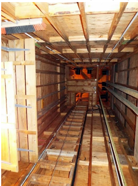
ホース乾燥塔を見上げる
