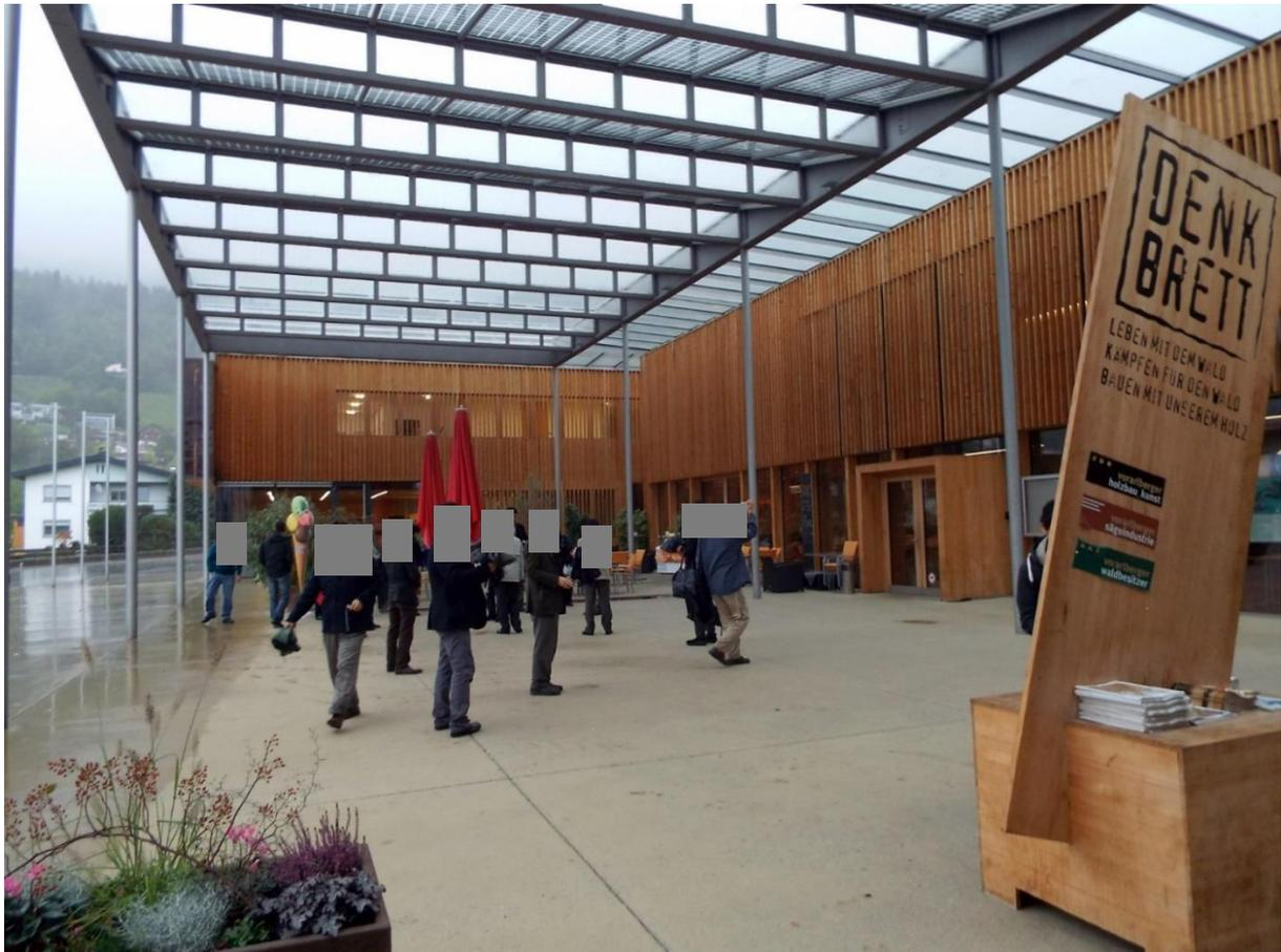
オーストリア・ルーデッシュ村の木造2階建て（地下1階）役場で、延べ面積3,135㎡、図書館や幼稚園も併設されています。人口2000程の村で住民参加による計画から設計までに数年掛けて、その後1年半の工期で2005年に竣工、建築時・使用時・解体時の省エネも考慮した設計で、年間一次エネルギー消費量や冷暖房負荷等で規定されたパッシブハウス基準を達成しているとのこと。屋根の断熱材は、ロックウール36cm+羊毛5cmもの厚さがあります。太陽光発電や太陽熱温水器パネルもあり、バイオマスボイラーによる地域暖房、地下水熱利用や熱交換換気システムも導入されています。可動間仕切壁で部屋のレイアウト変更を可能とする為に、構造的には木造の中に一部RC造や鋼管柱も併用されています。鉄骨造の広場屋根の柱（上写真参照）は、雨樋も兼ねているとのこと。内外装に無塗装のシルバーファー（マツ科）が用いられていますが、築8年でも反り狂いがほとんどない状態でした。含水率管理された良材が使われたものと思われる。色は次第に赤みを帯びてくるそうで、現在はもっと変退色が進んでいることと思われる。
