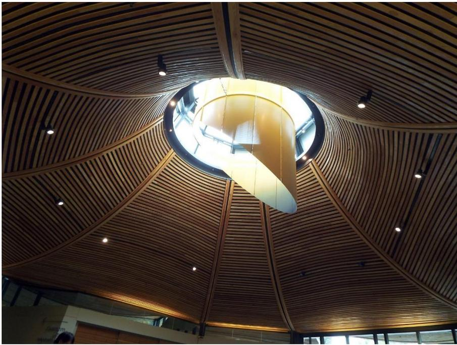
曲面屋根は工場生産の木製パネルで組立てられています。パネルの両側辺は湾曲集成材で、その間に2×8材が上下2段設けられ、上面には合板が張られ、上段2×8材（184mm成）の部分に高密度の断熱材が吹付けられ、2×8材上下の隙間がスプリンクラーや電気の配管スペースになっています。パネルは位置により曲率半径が異なるので、デザインから施工図作成や工場でのパネル製作まで、各段階でコンピュータが活用されたそうです。天井面は合板の小幅板の隙間と、それに続くパネル内の空洞とで、吸音性能が高められています。
