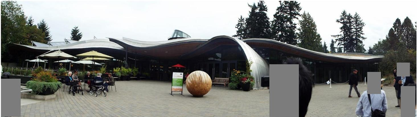
カナダ・バンクーバーのバンデューセンボタニカルガーデン（植物園）のビジターセンター、建築面積 1,858 m<sup>2</sup>の平屋木造建築物です。自生蘭の花びらを模した特徴ある形状の屋根に、一部植栽化、雨水収集システムと太陽熱温水システムを搭載し、地中熱も利用、さらに太陽光発電を建物脇の駐車場に設置して、必要な水・エネルギーは建物敷地内で生成、ゼロ水・ゼロエネルギーを達成した建物です。LEED（Leadership in Energy & Environmental Design）認証（エネルギーと環境デザイン・米国グリーン建築基準の認証）最高レベルのプラチナを取得し、さらに高いレベルのLBC（Living Building Challenge）認定（北米西海岸のCASCADIAグループの独自評価で、使用エネルギーを敷地内での再生可能エネルギーで100%賄うネットゼロエネルギーとネットゼロウォーターが必須条件）も取得しているとのこと。
