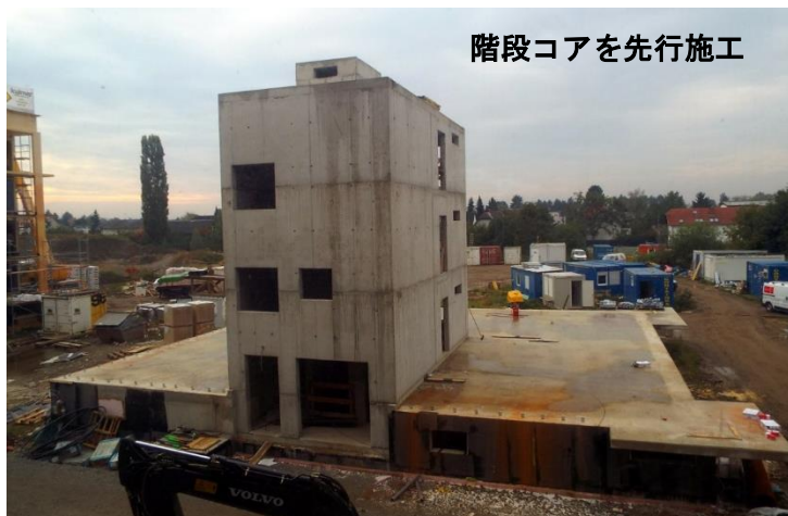
RC造階段コアとの緊結（水平力伝達）
