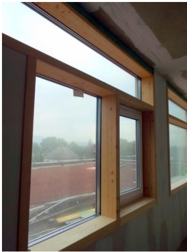
セクション1の外壁木造パネル
