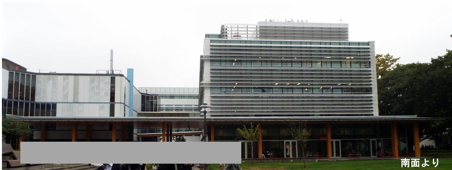
カナダ・バンクーバーにあるUBC (プリティッシュコロンビア大学) の、アースサイエンスビルディング、2012年竣工、延べ面積約 15,000 m<sup>2</sup>の5階建てビルです。南棟(実験棟、上写真)はRC造ですが、北棟(事務所棟)は木造で、柱:集成材、梁:集成材、ハイブリット(集成材+鉄)トラス、床:LSL (Laminated Strand Lumber)、R階の一部CLT(直交集成板)が、中央棟(アトリウム)も木造で、天井:CLT、階段:CLT(蹴上・踏面:集成材)が用いられています。日本の規定では、60分準耐火建築物に当たると考えられます。建物外周には集成材柱とCLTによる回廊(南面は3mの跳ね出し)が設けられています。
