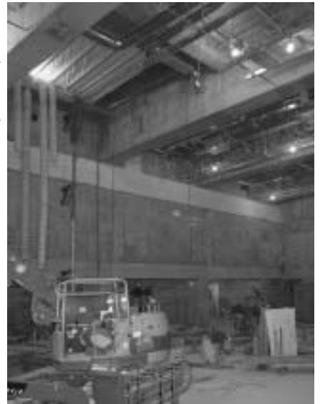
地下に設けられた体育館。左上の膜が張られている部分から掘削した土を取り出す
