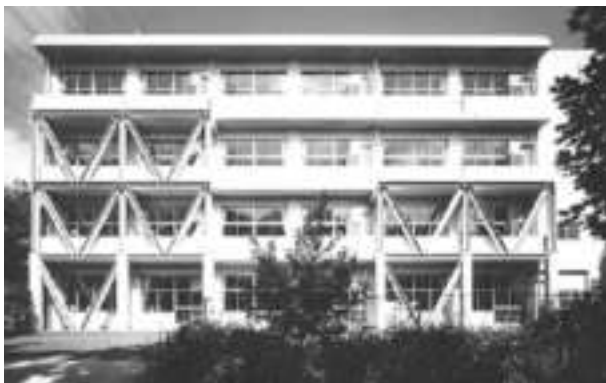
建物外部に耐震補強を行った事例
