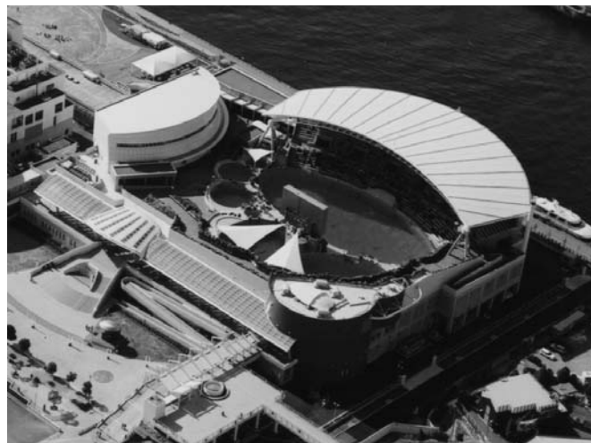
「名古屋港水族館第II期新築工事」
