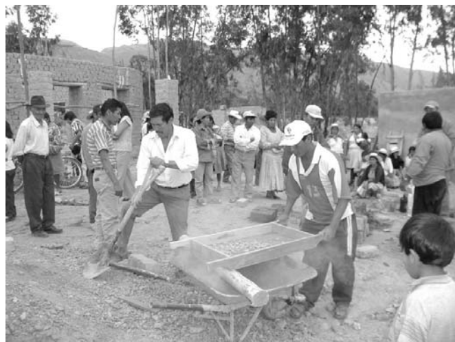
住民参加による建設風景
